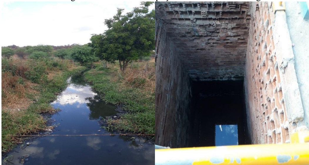
Figura 22-Riacho Exu e poço escavado as suas margens
