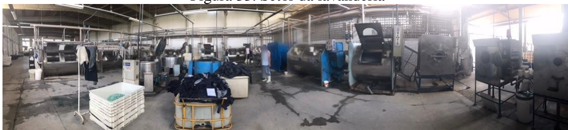
Figura 33. Setor da lavanderia
