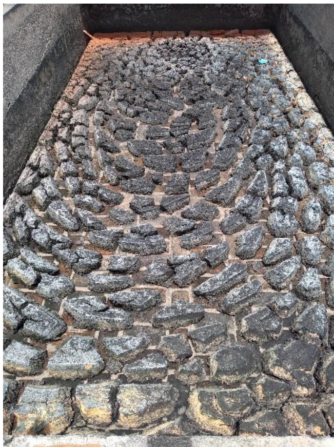
Figura 18 - Lodo no leito de secagem (final do processo de secagem).
