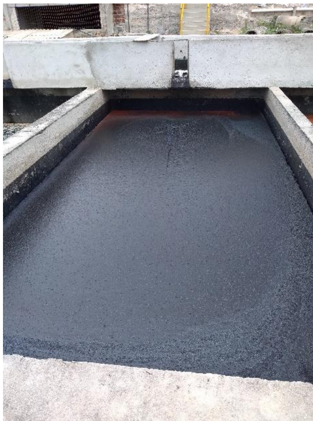
Figura 17 - Efluente no leito de secagem (início do processo de secagem).
