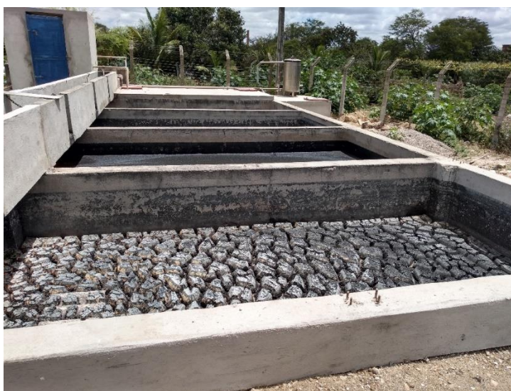
Figura 29 - Sistema de leito de secagem da lavanderia onde foi realizado o experimento.
