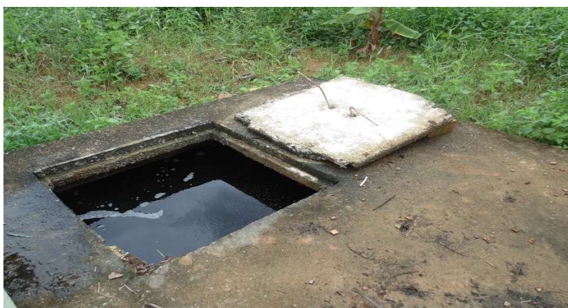
Figura nº 7 – Saída da ETE
