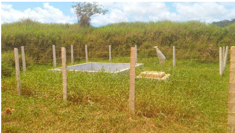
Figura nº 6 – Entrada da ETE
