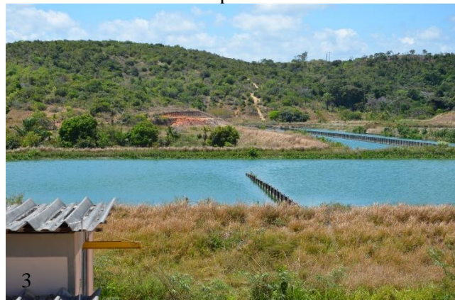
Figura 24 - Estação de tratamento de efluente municipal
