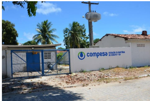
Figura 21 - Estação elevatória de esgoto
