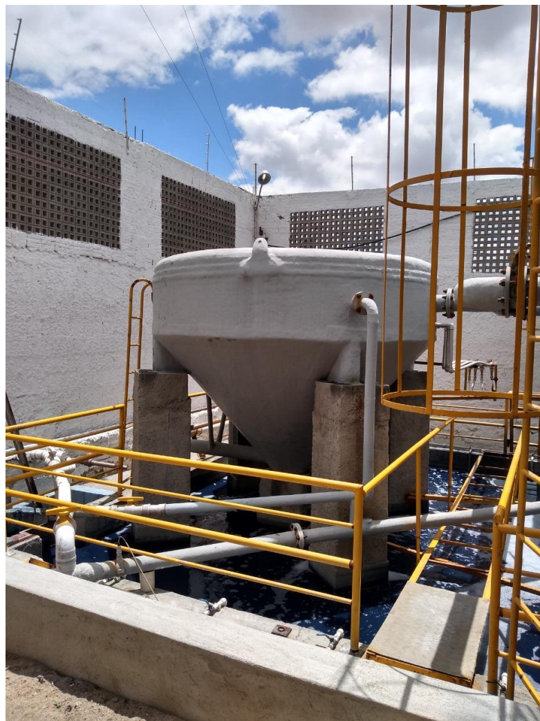
Figura 19. Adensador de Lodo da “ETE X”.
