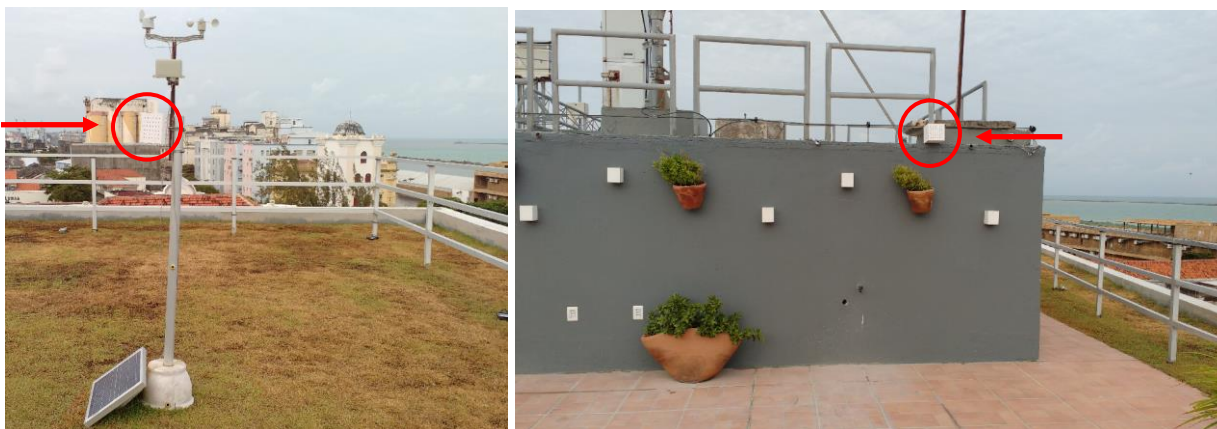
Figura 9. Vista dos protótipos instalados nos ambientes I e II.
