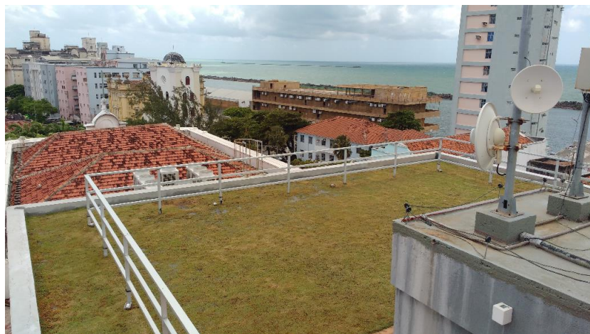
Figura 5. Vista parcial do Ambiente I, face norte, da laje do ITBC.
