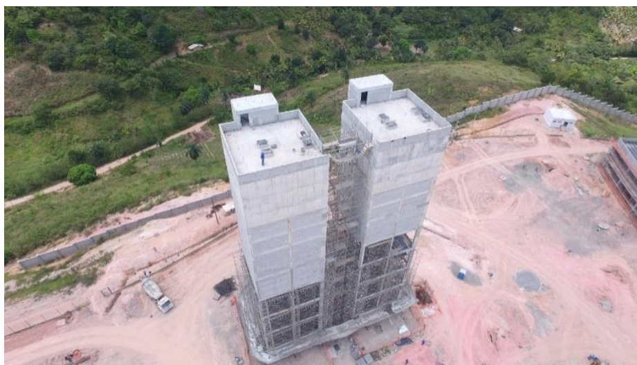
Figura 15. Execução dos reservatórios
