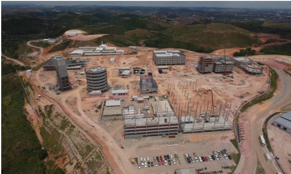
Figura 8. Desenvolvimento da obra em setembro de 2017
