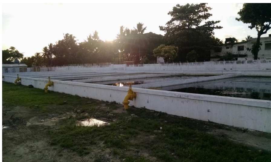
Figura 10. Leitos de secagem.
