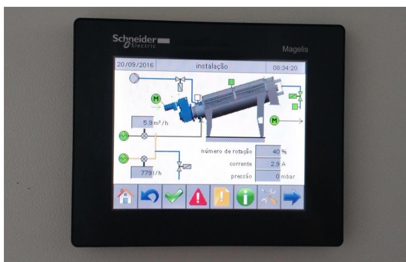
Figura 13. IHM do Skid.
