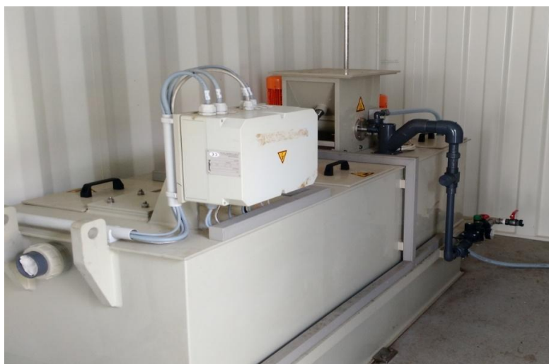
Figura 14. Preparador da solução de polímero.
