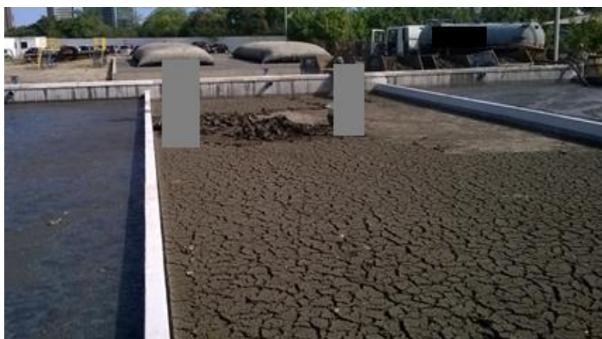
Figura 12. Leito de secagem.
