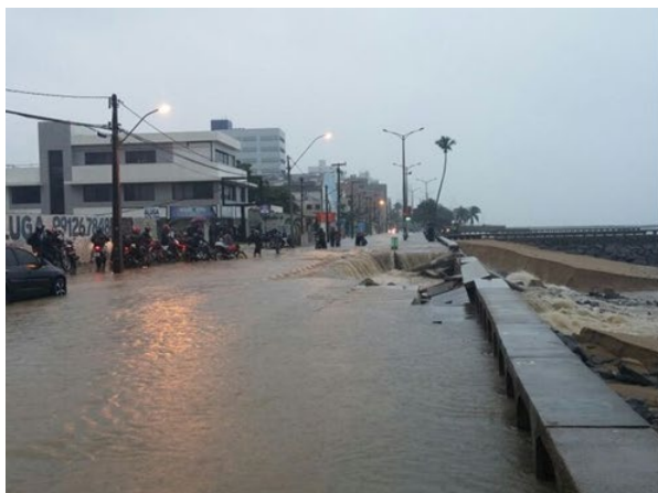
a) Afundamento de trecho do calçadão
