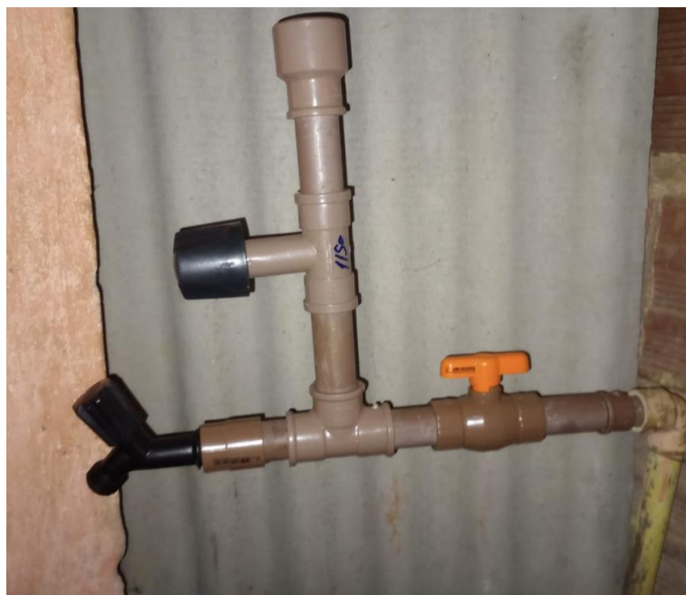
Figura 6: Clorador confeccionado e utilizado na pesquisa
