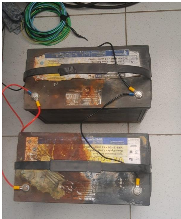
Figura 22: Banco de bateria.
