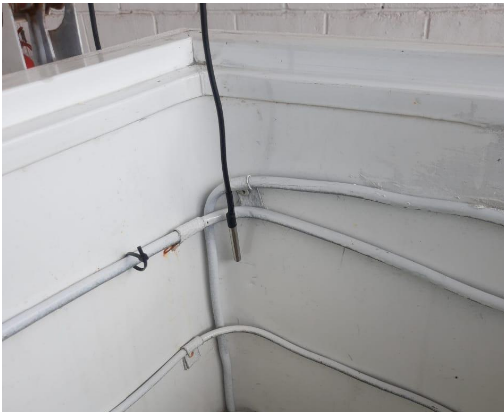
Figura 19: Sensor de temperatura, medição do ar passando na serpentina.
